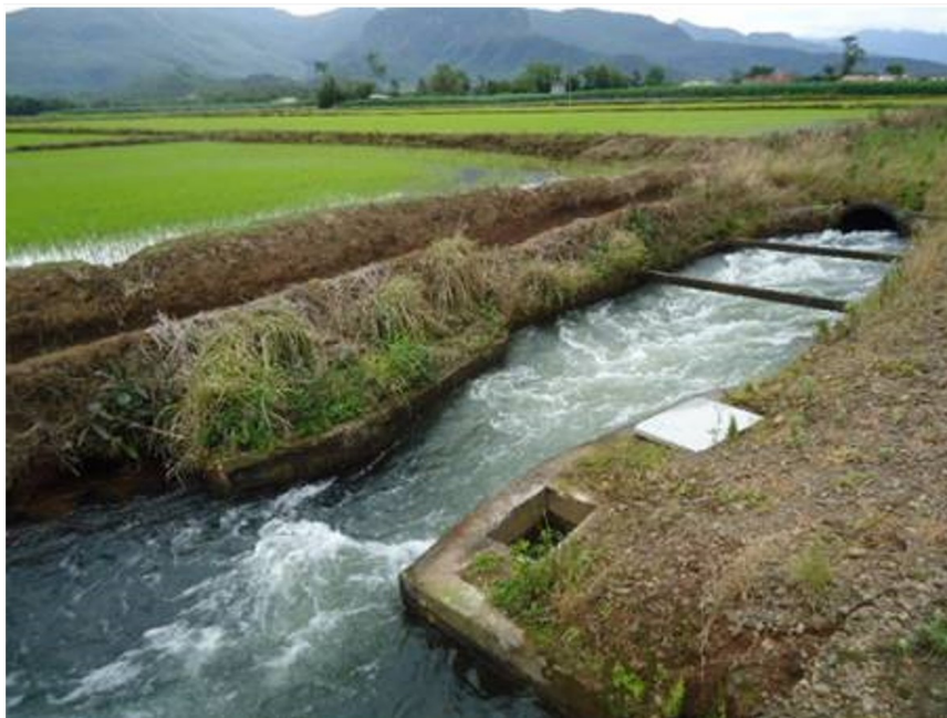
Figura 2. Calha Parshall para monitoramento da vazão de entrada na irrigação
